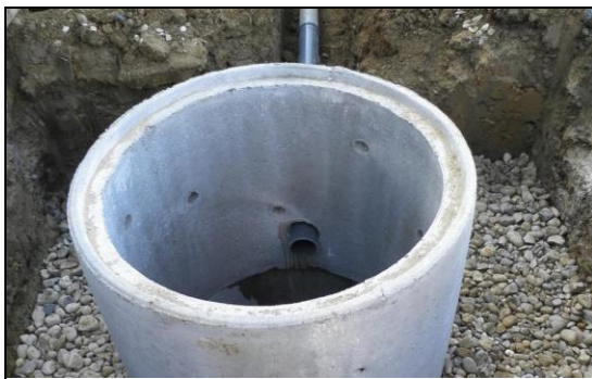
Puits d'infiltration
