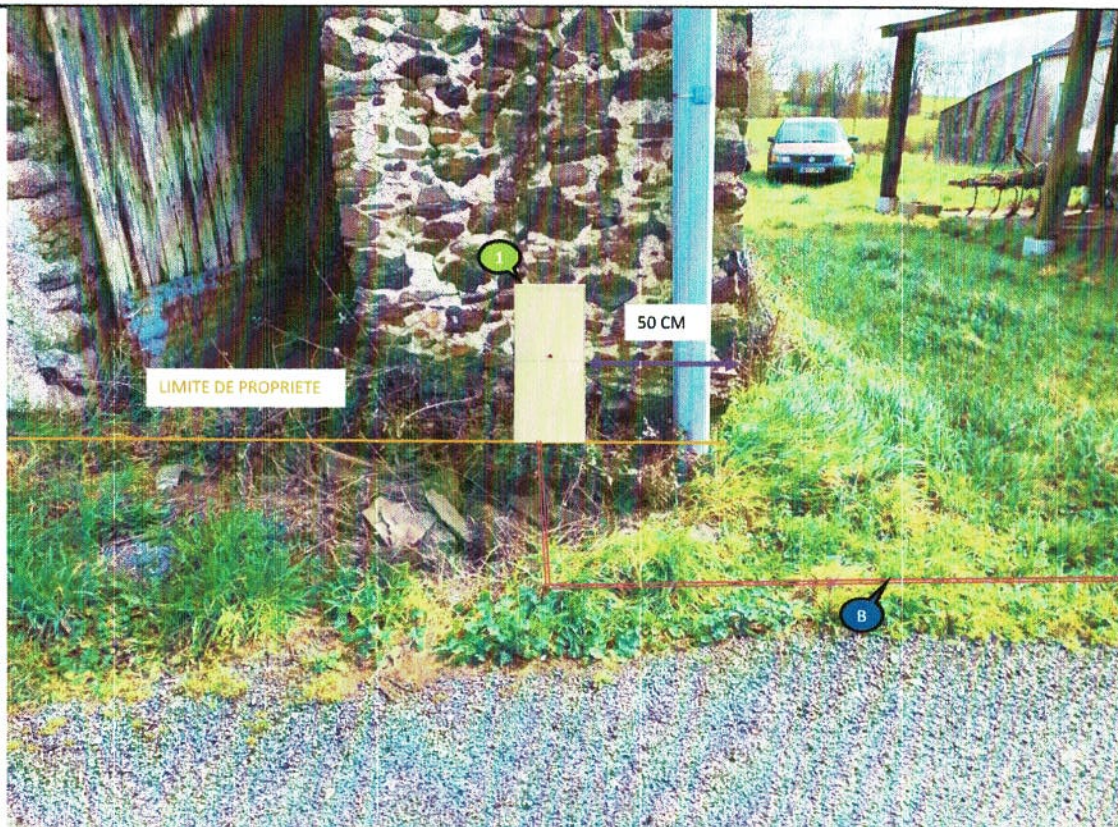
La solution technique est déterminée dans le respect de la norme NFC 14-100 en vigueur. Photo compteur non contractuelle
