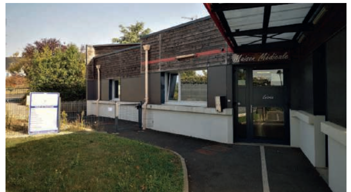
La partie de la maison médicale en travaux actuellement
