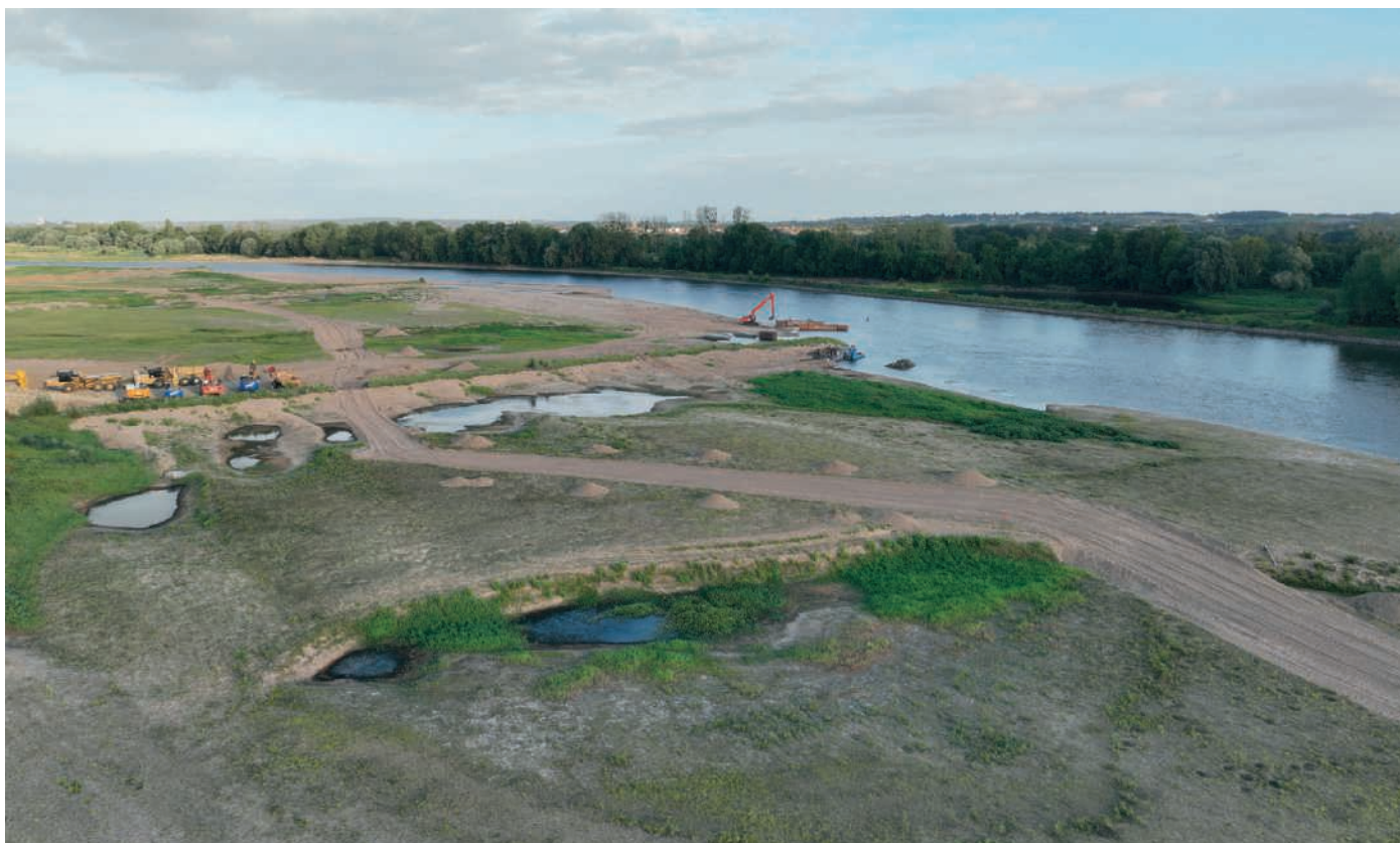
L'épi de la Chaussée, le camp de base et la mise à l'eau de barges - Photo : Pierre de Laubadère
