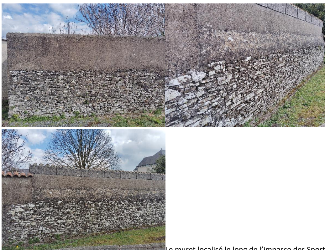
Le muret localisé le long de l'impasse des Sports
