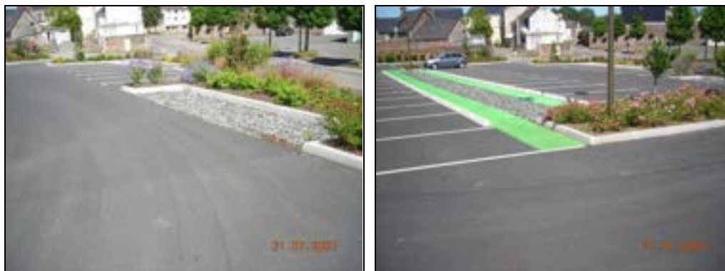
Photo 4 : Exemple de tranchées drainantes
