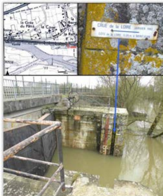
Photo 1 : Repère de niveaux de crues de la Loire à côté du « pont éclusé » de la Raffardière (ouvrage supportant la voie ferrée, marque de la crue de 1982)
