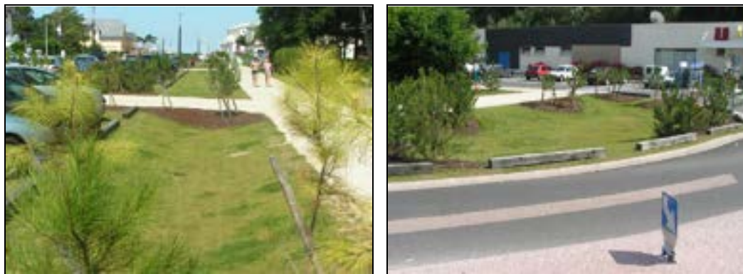
Photo 3 : Exemple de réalisation de noues paysagères
